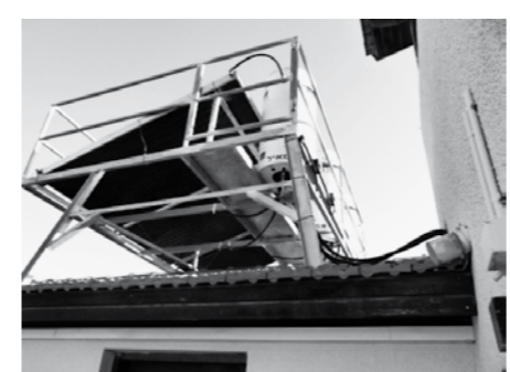
Sonnenkollektoren fürs warme Wasser auf dem Dach.
